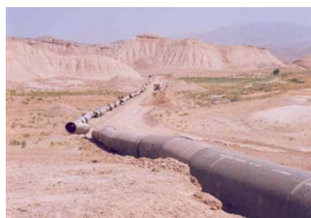
شکل شماره ۵- ریشه نمودن لوله
