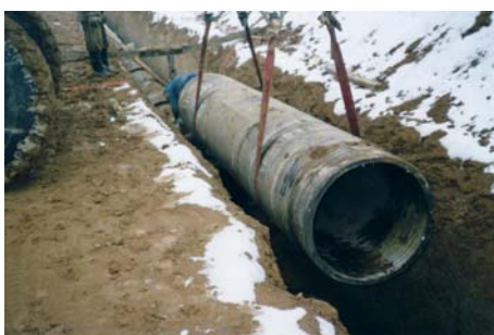
شکل شماره ۸- انتقال لوله به ترانشه
