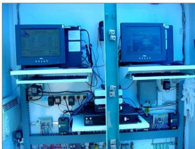
شکل ۱-۱۱ سیستم کنترل الکترونیکی از راه دور ایستگاه
