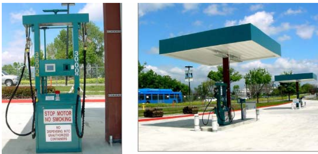
شکل ۱-۱۴ سیستم توزیع کننده CNG به خودروها
