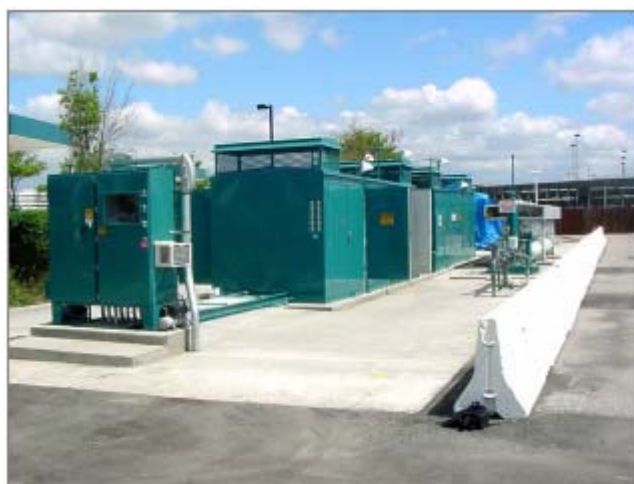
شکل ۱-۶ محفظه و موقعیت کمپرسور در ایستگاه سوخت رسانی
