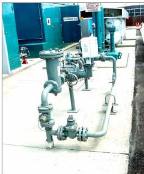
شکل ۱-۴ سیستم اندازه گیری گاز در ورود به درایر
