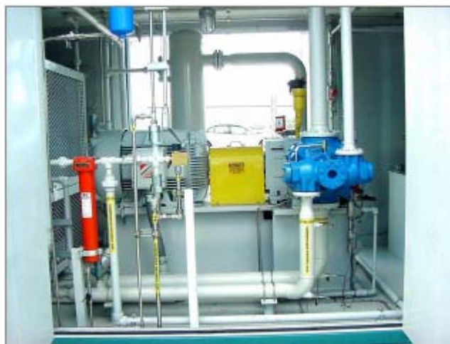
شکل ۹-۱ کمپرسور سه مرحله ای
