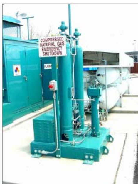
شکل ۱-۵ نمونه ای از درایر و فیلتر گاز در ایستگاه CNG
